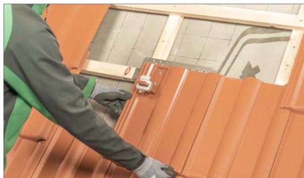
2. Setzen Sie die D-Platte für den zu ersetzenden Ziegel ein.
