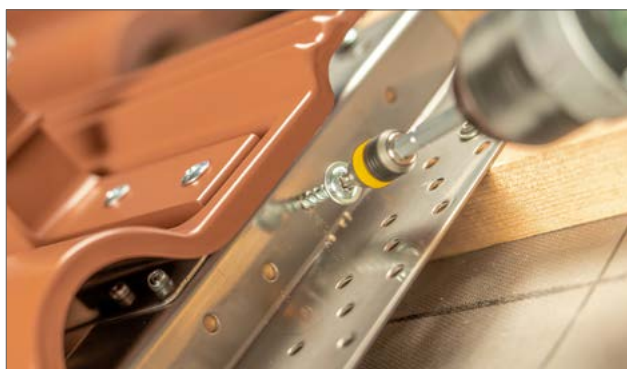
3. Schrauben Sie die D-Platte an der Konterlattung und der Querlattung fest. Nutzen Sie hierzu 2x Tellerkopfschrauben (Art.-Nr. 92107-35) und 1x Tellerkopfschraube (Art.-Nr. 92107-10).
