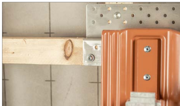
3. Schrauben Sie die D-Platte an der Konterlattung und der Querlattung fest. Nutzen Sie hierzu 2x Tellerkopfschrauben (Art.-Nr. 92107-35) und 1x Tellerkopfschraube (Art.-Nr. 92107-10).
